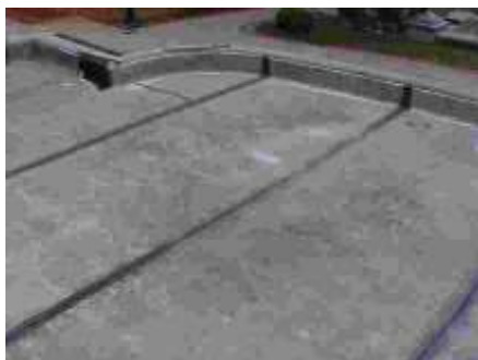
STRUJUNTA ® aplicado em juntas de dilatação.
